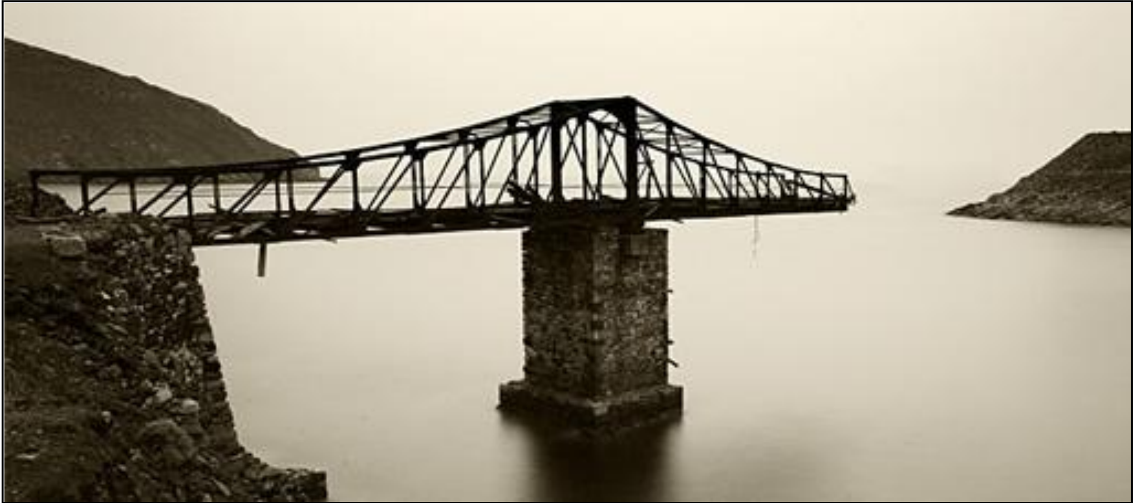
Bridge to „nowhere“
